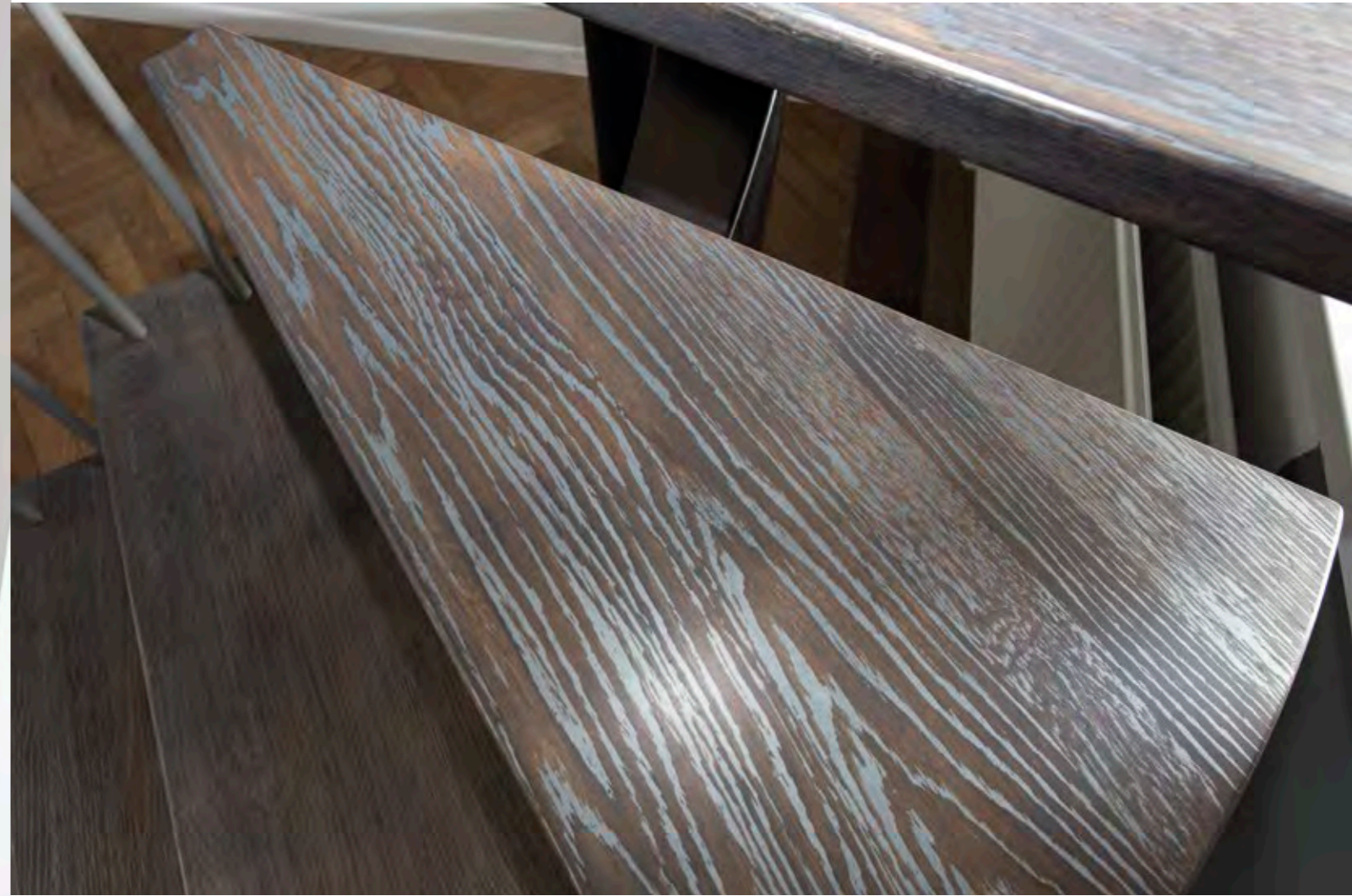
Durchgängiges Gestaltungselement Holz: in Spachteltechnik veredelte, massive Stufenelemente
