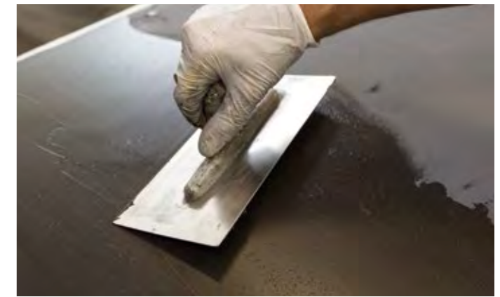
2. Anschließend wird die vorbereitete Spachtelmasse dick aufgetragen.
