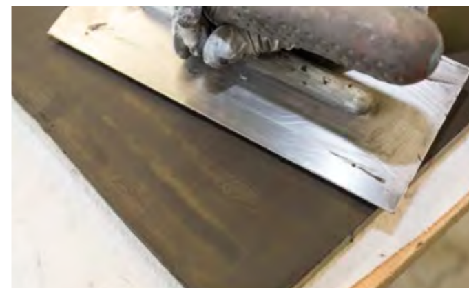
3. Durch das mehrfache Abtragen der Spachtelmasse entsteht die metallisch schimmernde Oberfläche.
