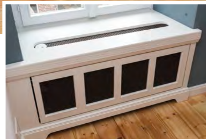
Stimmig gestaltete Heizkörperverkleidungen im gesamten Objekt
