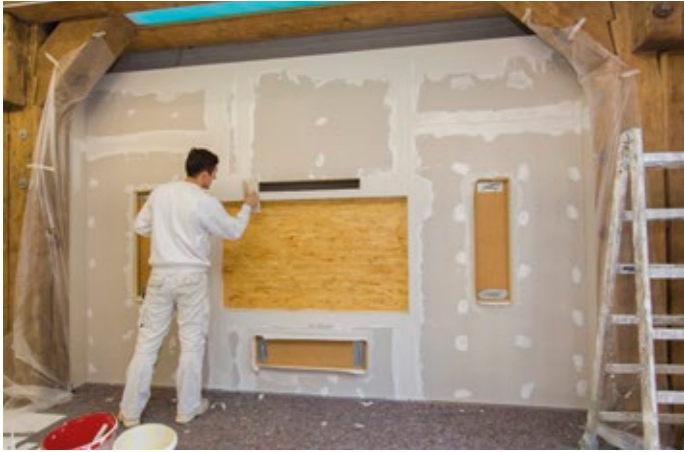
Spachteln der Fugen und Übergänge
