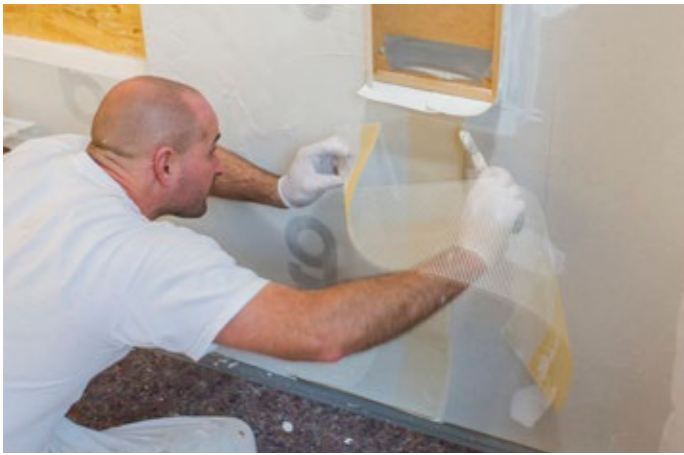
Fasermatten als Trägermaterial für die spätere Spachtelmasse
