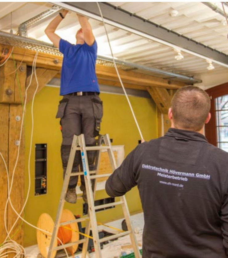
Das Team von Elektrotechnik Hövermann bei der Verkabelung
