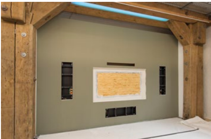
Voranstrich/Grundierung der Medienwand
