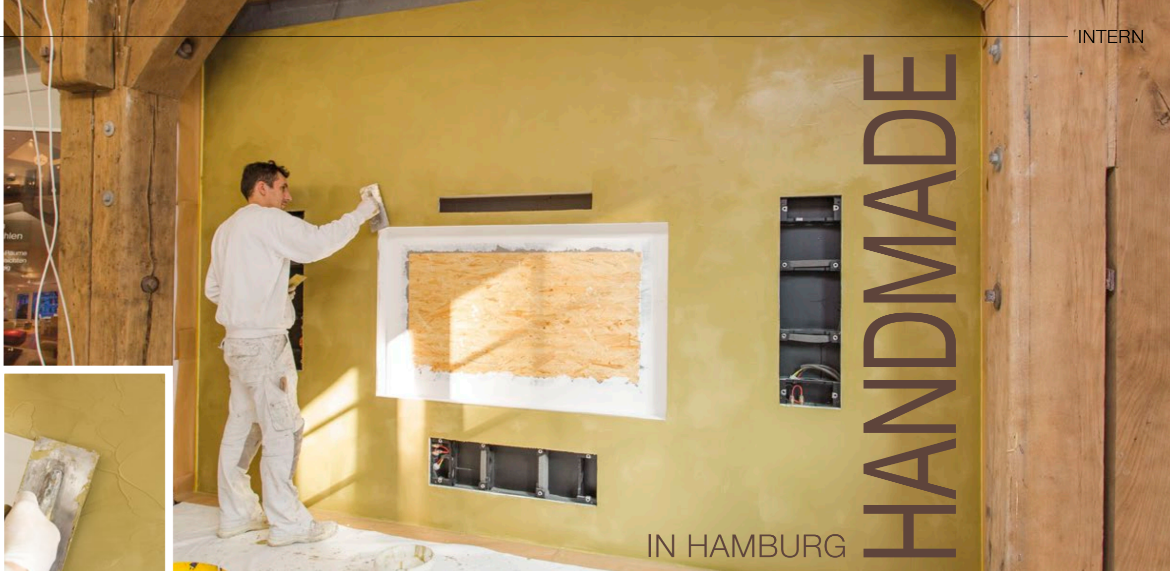
Aufbringen der Spachtelmasse mit bis zu 96 % Messing-Anteil
