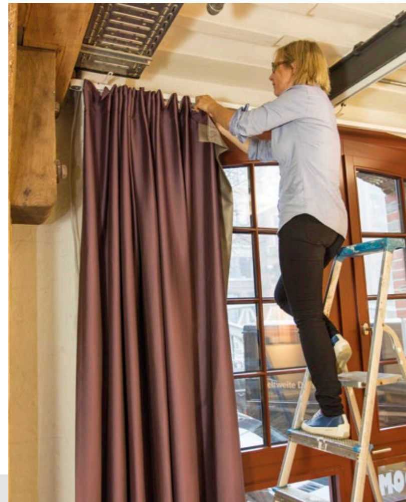
Unsere Raumausstatterin Imme Witt bei der Montage der elektrisch angetriebenen Vorhänge
