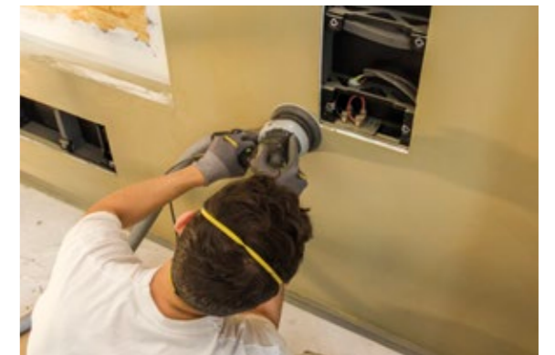
In vielen Schritten wird die Wand abgeschliffen
