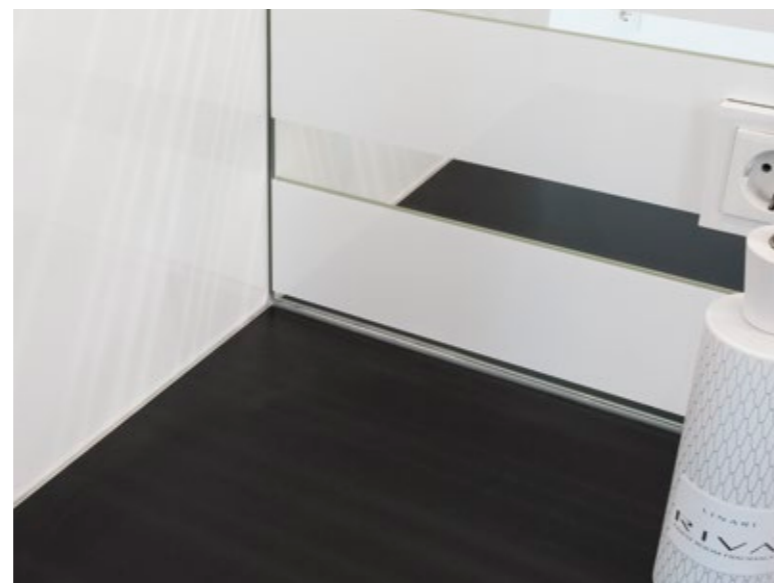
Hoher hygienischer Standard durch Glasflächen im Küchenbereich
