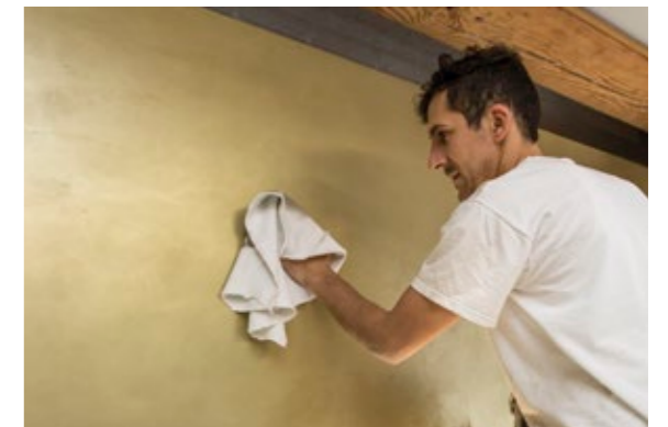
Endreinigung der Metall X-Oberfläche in Messing
