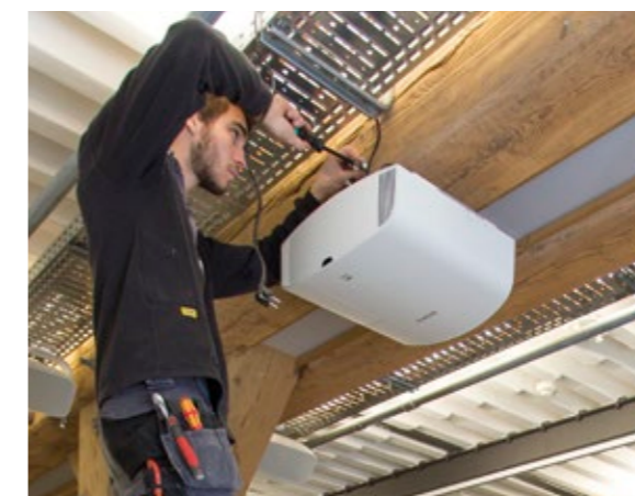
Montage des 4K-Beamers von Sony
