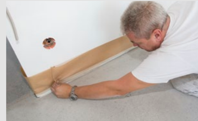
Schritt 5: Alle Kanten werden großflächig abgeklebt
