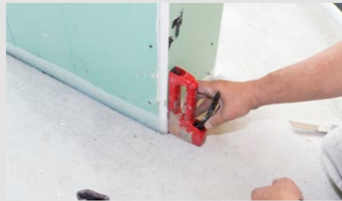
Schritt 2: ... und auf die Gipswände getackert
