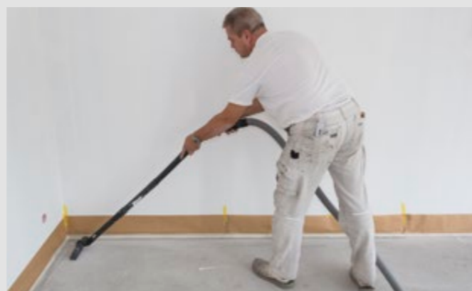
Schritt 12: Zur Vorbereitung der Grundierung müssen alle Flächen gründlich gefegt und abgesaugt werden
