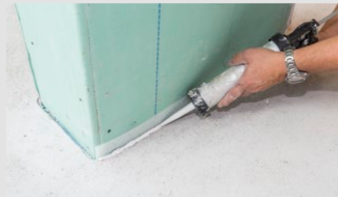
Schritt 3: Anschließend wird eine Acrylmasse aufgetragen ...
