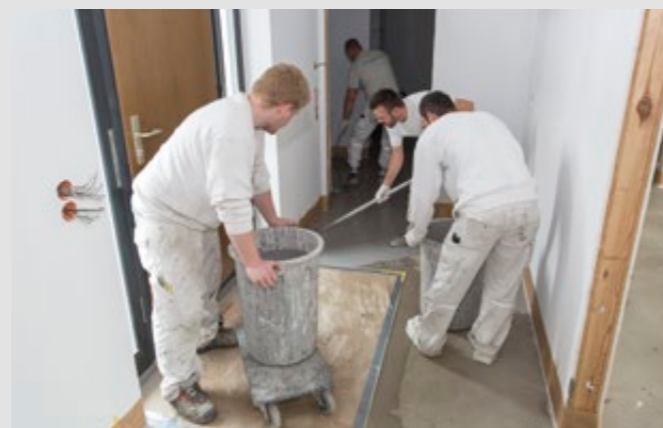
Schritt 14: Ausgießen und Verteilen des flüssigen Bodenmaterials
