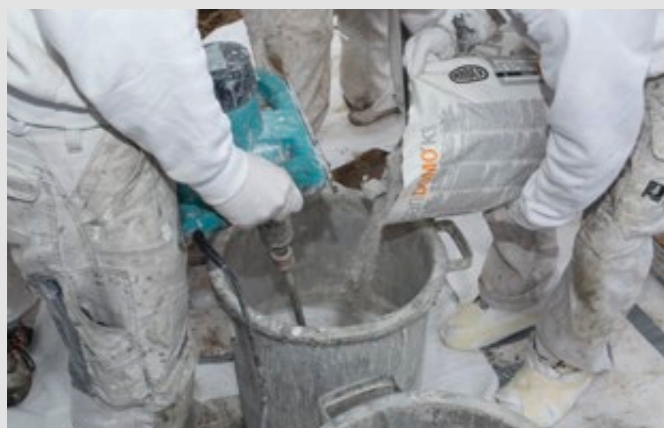
Schritt 13: Vorbereitung des Grundwerkstoffes und eventueller Zusätze wie z. B. Farbpigmente
