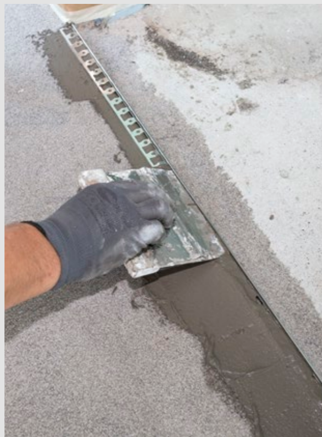
Schritt 9: Wichtig ist das genaue Bearbeiten der Edelstahlleisten für einen sauberen Übergang zu den Duschflächen
