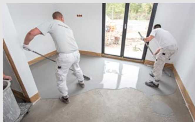
Schritt 14: Wichtig ist das schnelle und gleichmäßige Verteilen der Masse – auch der Nachschub muss zügig „fließen“
