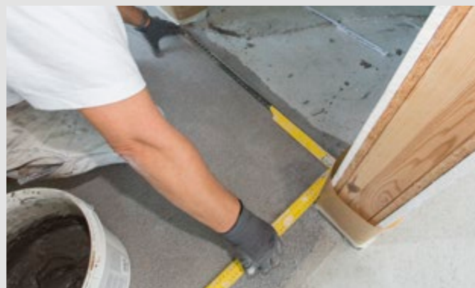
Schritt 8: Sauberes Ausrichten von Duschkanten/Abschlussleisten
