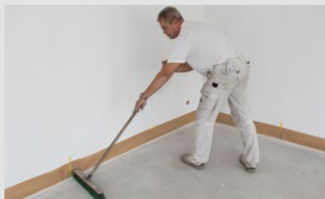
Schritt 12: Zur Vorbereitung der Grundierung müssen alle Flächen gründlich gefegt und abgesaugt werden
