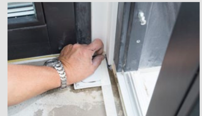
Schritt 7: Alle zu schützenden Flächen müssen sauber abgeklebt werden
