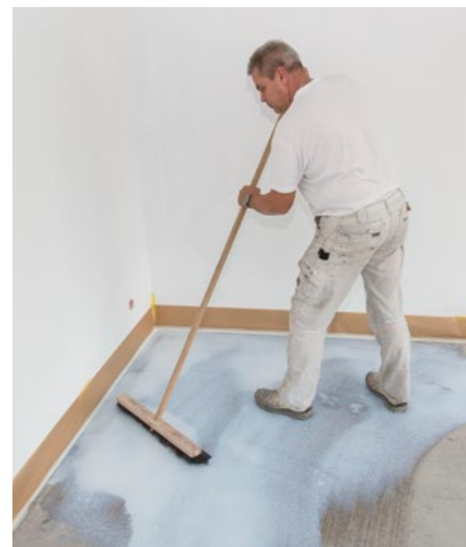
Schritt 13: Aufbringen der Grundierung
