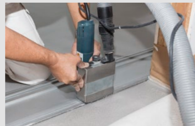
Schritt 16: professionell hergestellte PANDOMO-Böden bekommen an den Zimmerübergängen zum Ausgleich der Kräfte eine saubere Fuge, welche später fast unsichtbar versiegelt wird
