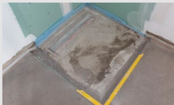
Schritt 8: Einpassen/Ausrichten einer ebenerdigen Eckdusche
